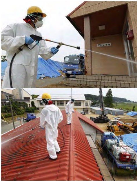
除染作業の様子
